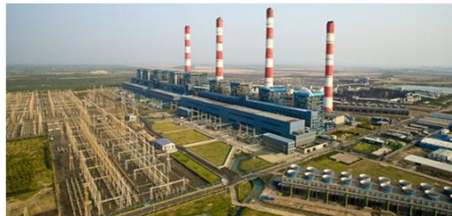
Adani Power Mundra石炭火力発電所
