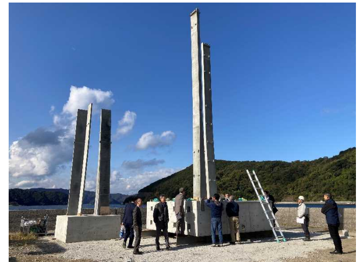
背の高い基盤ブロック（高さ10m）
