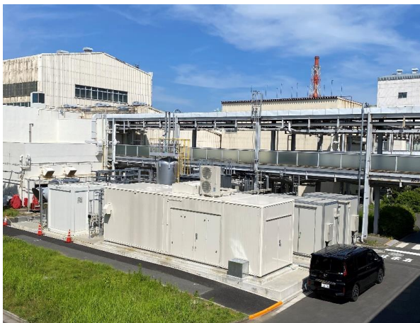
CO 2 フリー水素製造 (水電解設備)
