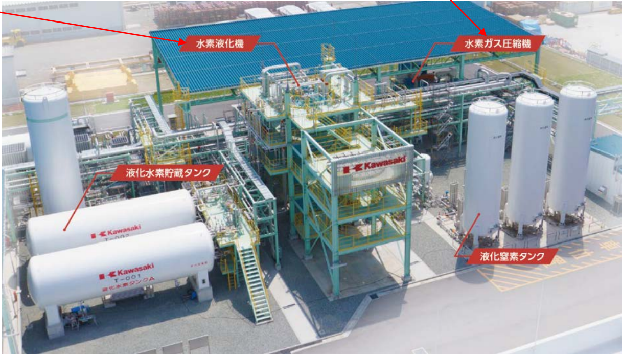
実際の5t/dの液化システム（川崎重工業製）
