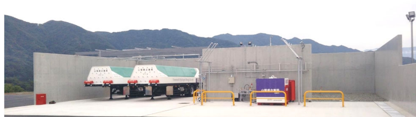
水素出荷設備 19.6MPa 400Nm3/h
