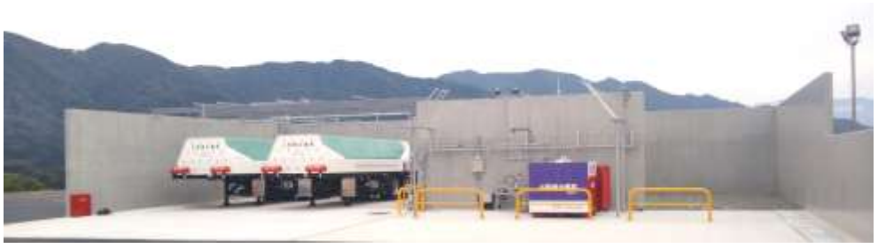
水素出荷設備 19.6MPa 400Nm3/h
