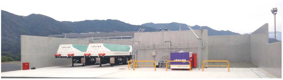
水素出荷設備 19.6MPa 400Nm3/h
