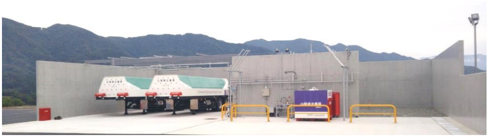
水素出荷設備 19.6MPa 400Nm3/h
