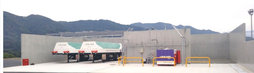
水素出荷設備 19.6MPa 400Nm 3 /h
