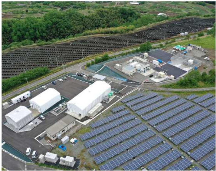
電力貯蔵技術研究サイト全景
