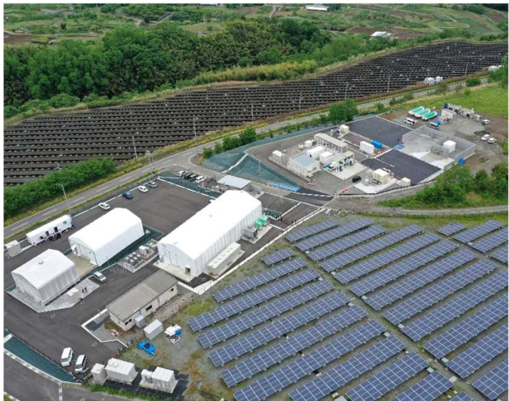
電力貯蔵技術研究サイト全景
