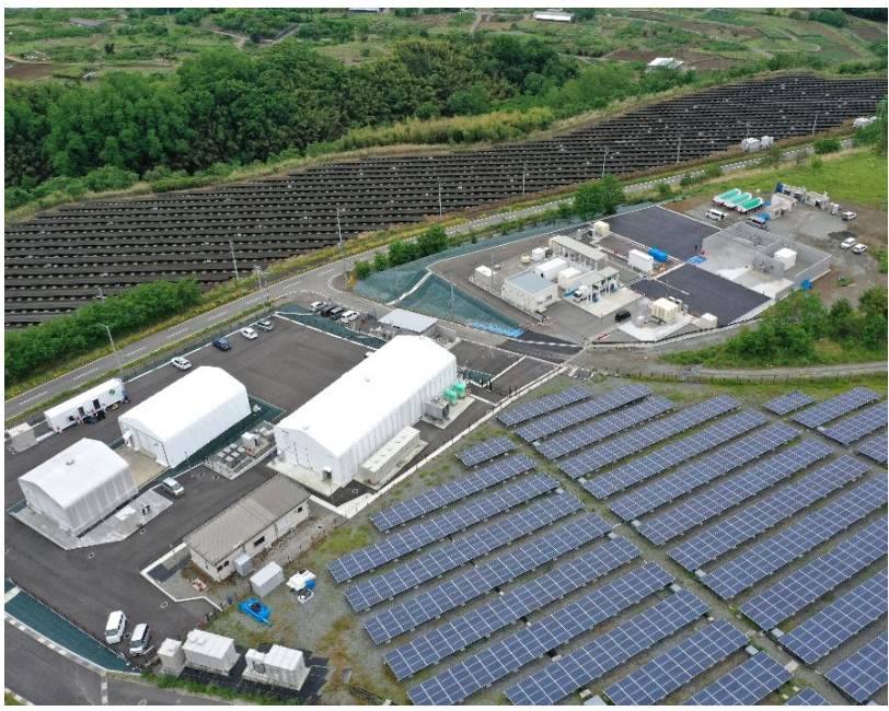
電力貯蔵技術研究サイト全景
