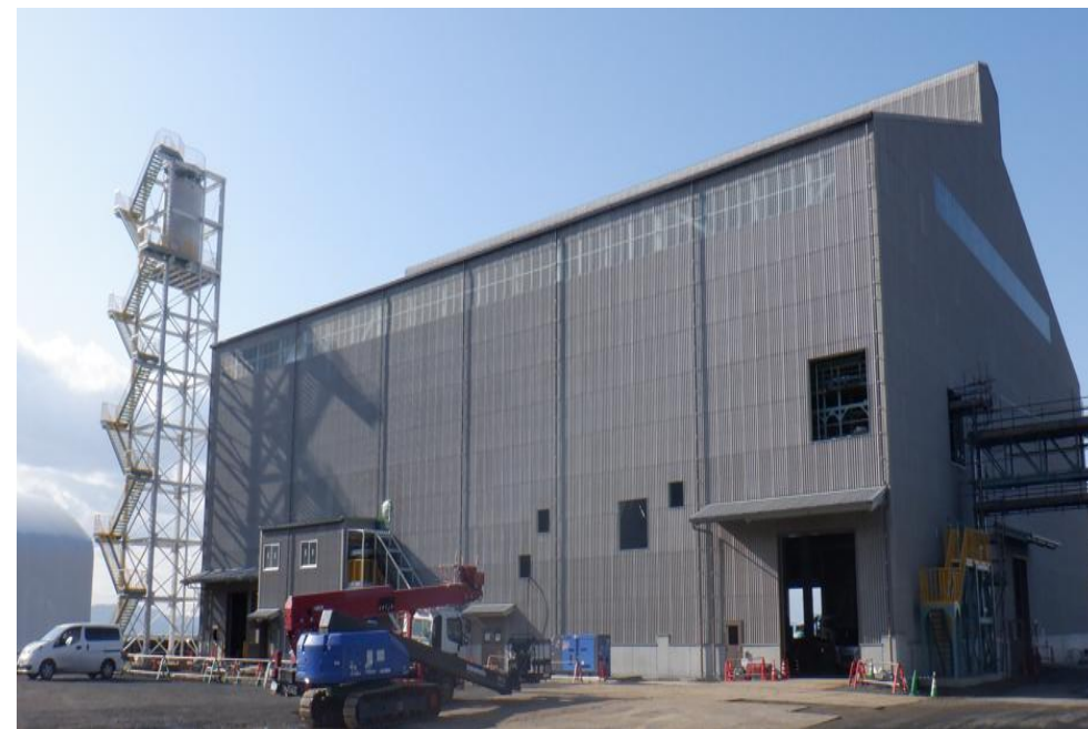
図 プレ商業実証プラント建設中の様子
