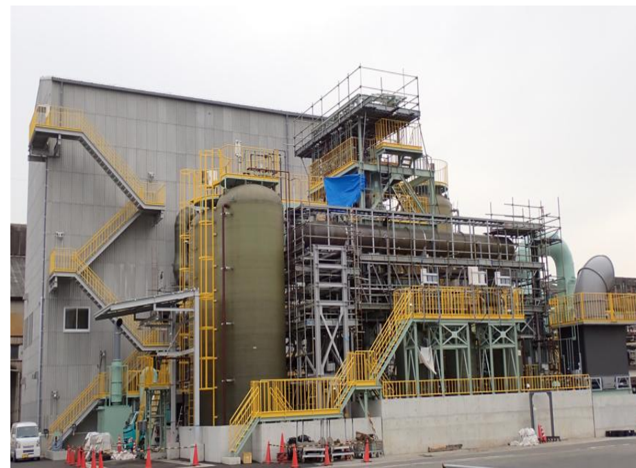
図 プレ商業実証プラント建設中の様子
