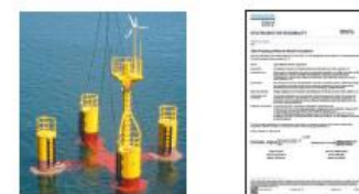
大型風車対応の4本コラムセミサブ型風車浮体（スケールモデル） DNVが取得したSOF證書
