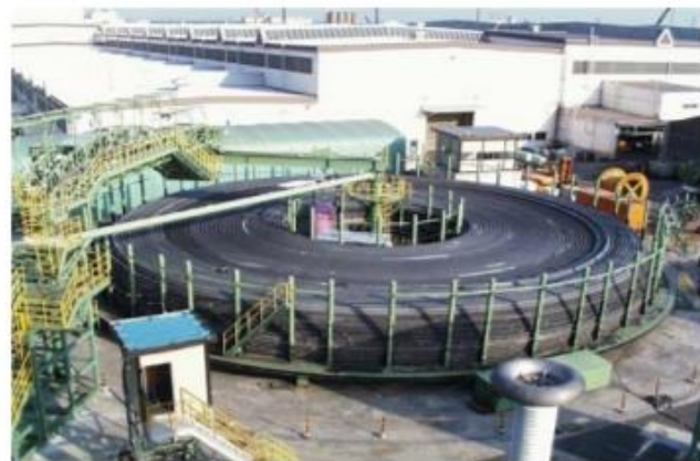
海底線製造設備(千葉工場)
