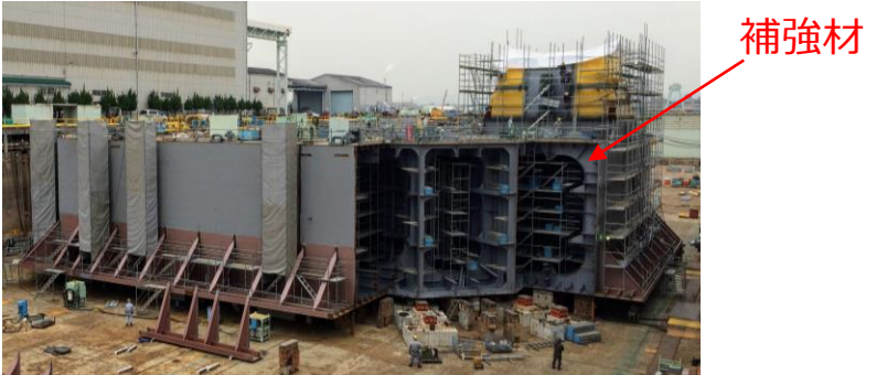
バージ型実証機 製作中の写真
