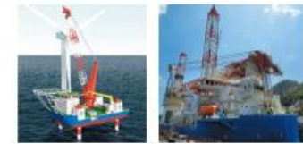
SEP型多目的設置船「CP-8001」 建造中のSEP船（英）
