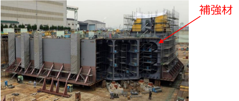
バージ型実証機 製作中の写真
