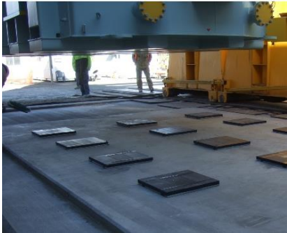
【写真：防振ゴムの使用例】
