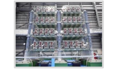
HVDC変換器
