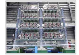
HVDC変換器
