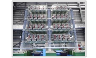
HVDC変換器
