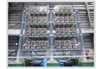
HVDC変換器
