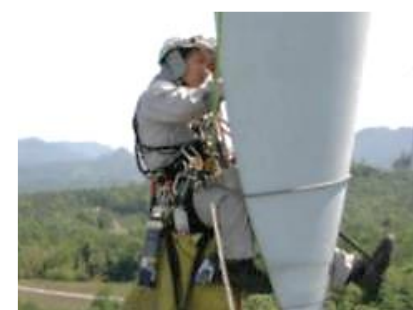
従前の導通試験状況
