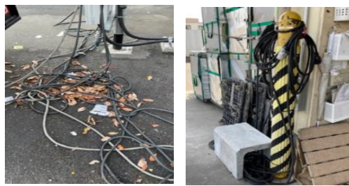
充電器ケーブルの危険な状態 （ケーブル損傷、漏電、火災リスク増加）
